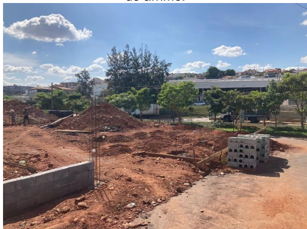
Figura 04: Vista do terreno em execução de muro de arrimo.
