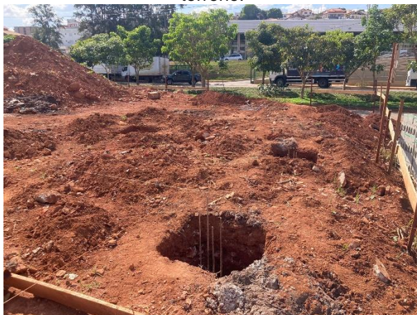
Figura 05: Vista da fundação sendo feita no terreno.
